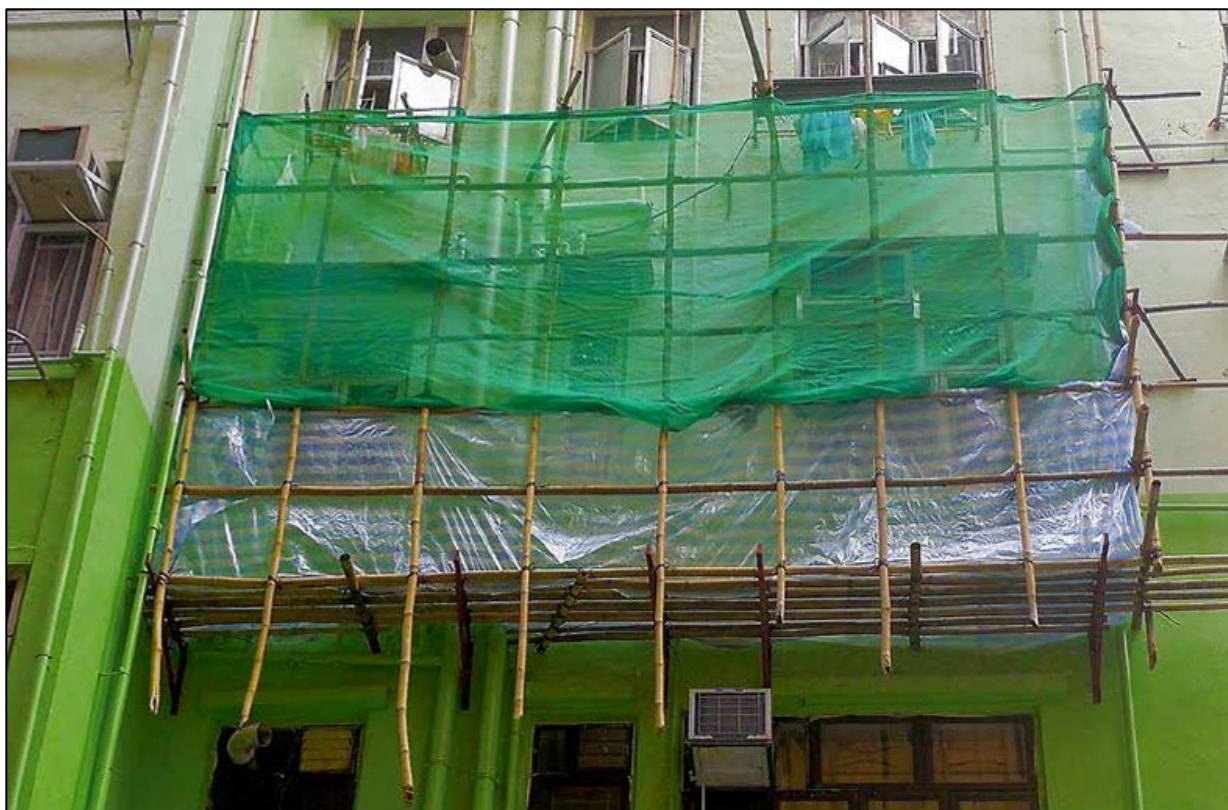
懸空式竹棚架（俗稱「吊棚」／「飛棚」）
